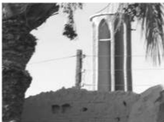
شکل ۳- نمایی از یک بادگیر استوانه‌ای شکل با سطح مقطع دایره‌ای در بافق
