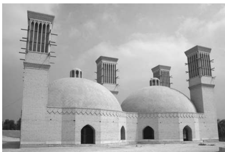
شکل ۱۰- آب‌انباری با پنج بادگیر و دو سقف‌گنبدی در جزیره کیش
