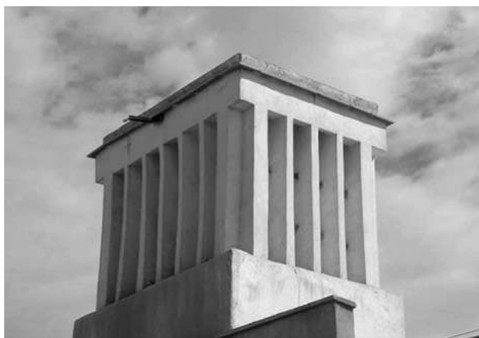
شکل ۱۱- نمایی از بادگیری کوتاه و حجیم در خور
