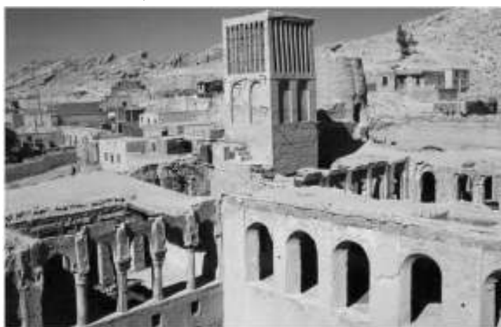
شکل ۱۲- تصویری از بادگیر چهار طرفه قلعه شیخ در بندر سیراف، بوشهر (بادگیر در چند متری خلیج فارس می‌باشد).
